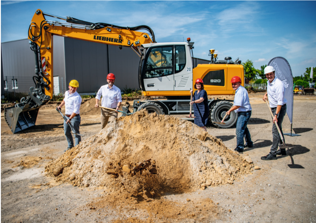
Der offizielle Spatenstich erfolgte am 23.08.2022 mit der Bürgermeisterin und dem Architektenteam.
